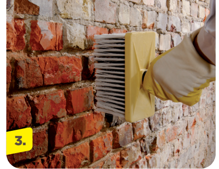
3. Untergrund mattfeucht vornässen.
