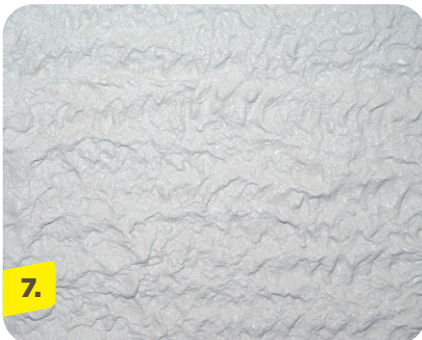
7. Kontaktschicht aus Sanierputz weber.san 958 vollflächig auf den mattfeucht vorgehängten Untergrund aufziehen und optimalerweise frisch horizontal aufkämmen.
