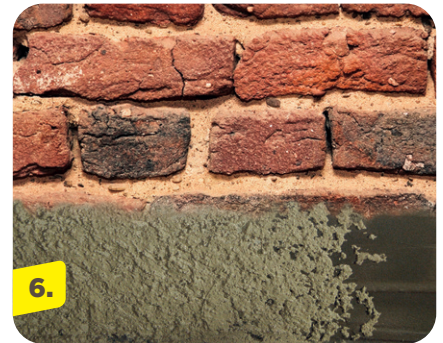
6. Vorspritz aus weber.san 951 S vollflächig auf durchgetrocknete Abdichtung aus webertec Superflex D 24 aufbringen.
