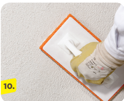
10. Nach ca. 90 Minuten Oberfläche mit einem mattfeuchten Schwammbrett abreiben.
