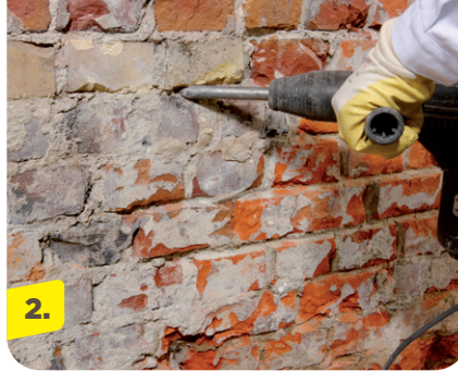
2. Mauerwerksfugen sind mind. 20 mm tief auszuräumen.
