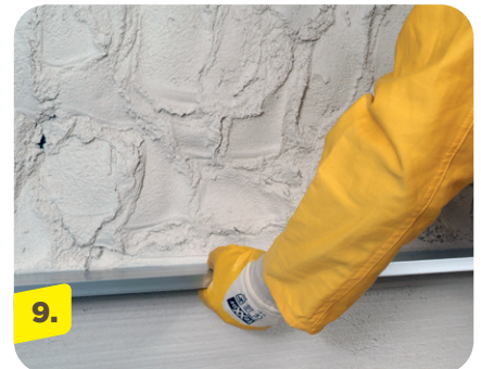
9. Oberflächen mittels Kartätsche egalisieren.
