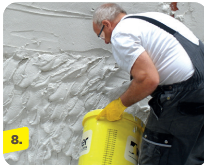
8. Frisch in frisch Sanierputz einlagig in Schichtdicken bis max. 40 mm aufbringen.
