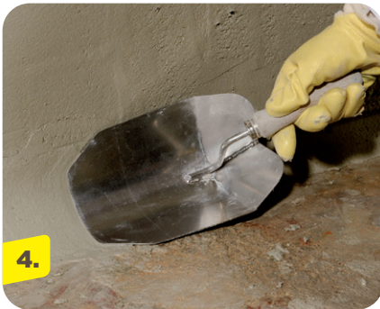
4. Hohlkehle aus webertec 933 frisch in frisch ausrunden.
