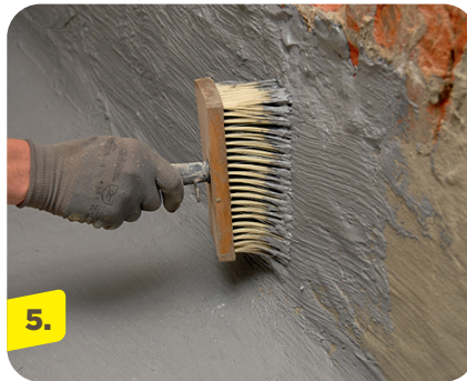
5. Nach Grundierung wird im Übergangsbereich eine Abdichtung aus webertec Superflex D 24 vollflächig bis ca. 20 cm überlappend in den Wand-/Bodenbereich hinein aufgetragen.
