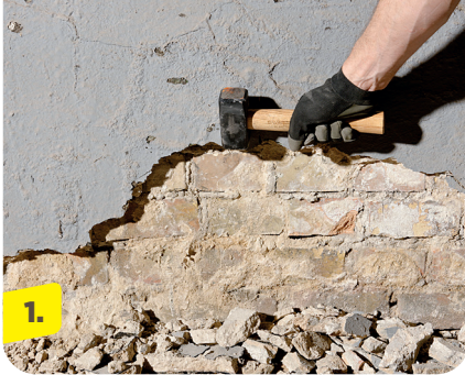
1. Untergrund reinigen: Altputz bis mind. 80 cm oberhalb des Feuchtheizontes entfernen.
